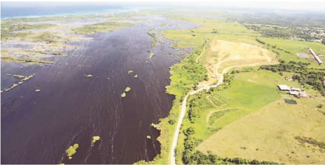
El vertedero de Arecibo, ubicado en la reserva natural del Caño Tiburones, ha incumplido con varios requerimientos federales.
